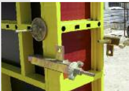
Exemple de fermeture d'about de voile à l'aide d'un bloc réglable standard
