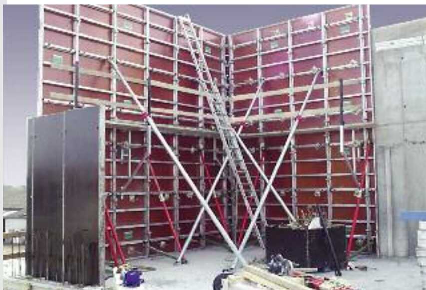
Exemple de travaux en superposition
