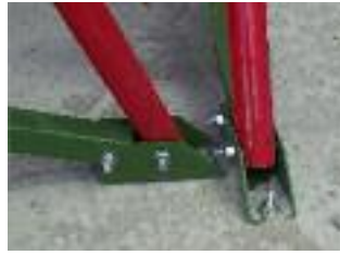
Ancrage sur dalle du sabot de béquille
