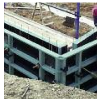
Assemblage par bloc variable des fourrures sur angle extérieur.
