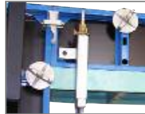
Coffrage de lindeau
