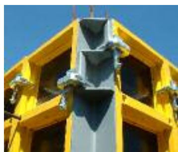
Assemblage et jonction d'angle intérieur et extérieur
