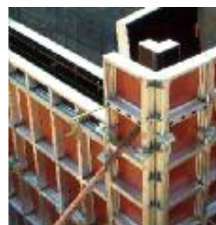
Assemblage et jonction d'angle intérieur et extérieur
