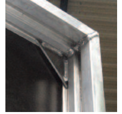
Renforts des angles par goussets 80x80 ép.5mm
