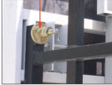
4 anneaux de levage sur ossature.
