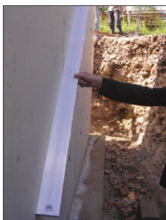
Planéité du béton après décoffrage conforme aux DTU les plus stricts. ( Suivant nos recommandations de coulage ).
