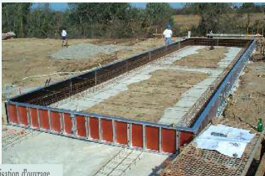
Coulage d'un massif hors sol, sans tige, sans écrou et sans éclisse d'alignement. Reprise de poussée béton par tendeurs extérieurs.
