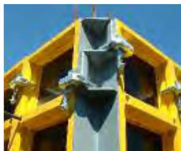
Assemblage et jonction d'angle intérieur et extérieur
