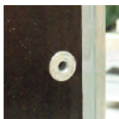
Rivets coniques têtes fraisées
