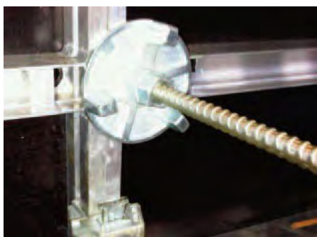
Assemblage tige écrou
