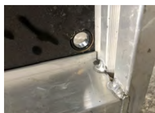
Passage de tige avec bague CP 15 mm PVC
