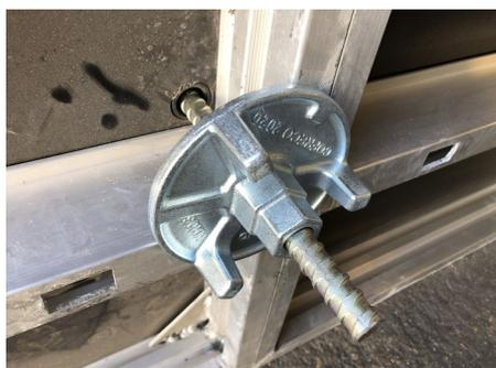
Assemblage tige écrou
